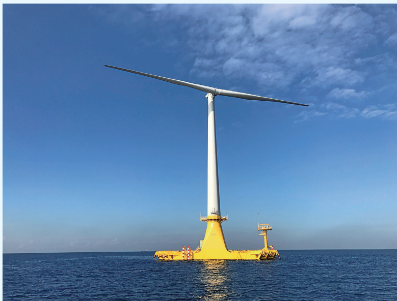
図8 バージ型浮体式洋上風力発電システム実証機 出典：NEDO 40 年史
