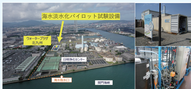
図2 海水淡水化パイロット試験設備：『ロバストナノカーボン複合膜』の性能を実海水にて検証 (約 5t/day を海水から造水できる仕様：北九州市小倉)
